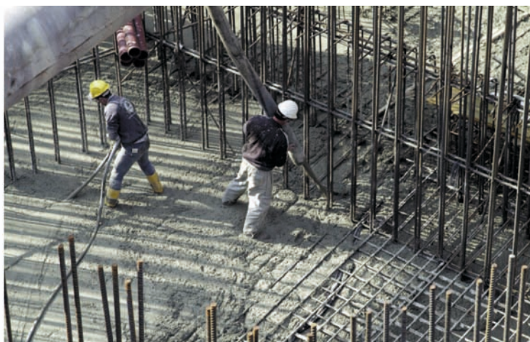
Getto plinto - Cantiere a Piacenza
