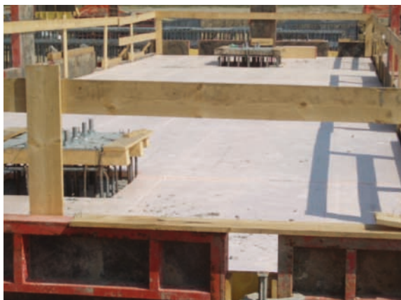
Protezione della superficie superiore di un blocco di fondazione con pannelli termoisolanti per la riduzione dei gradienti.
