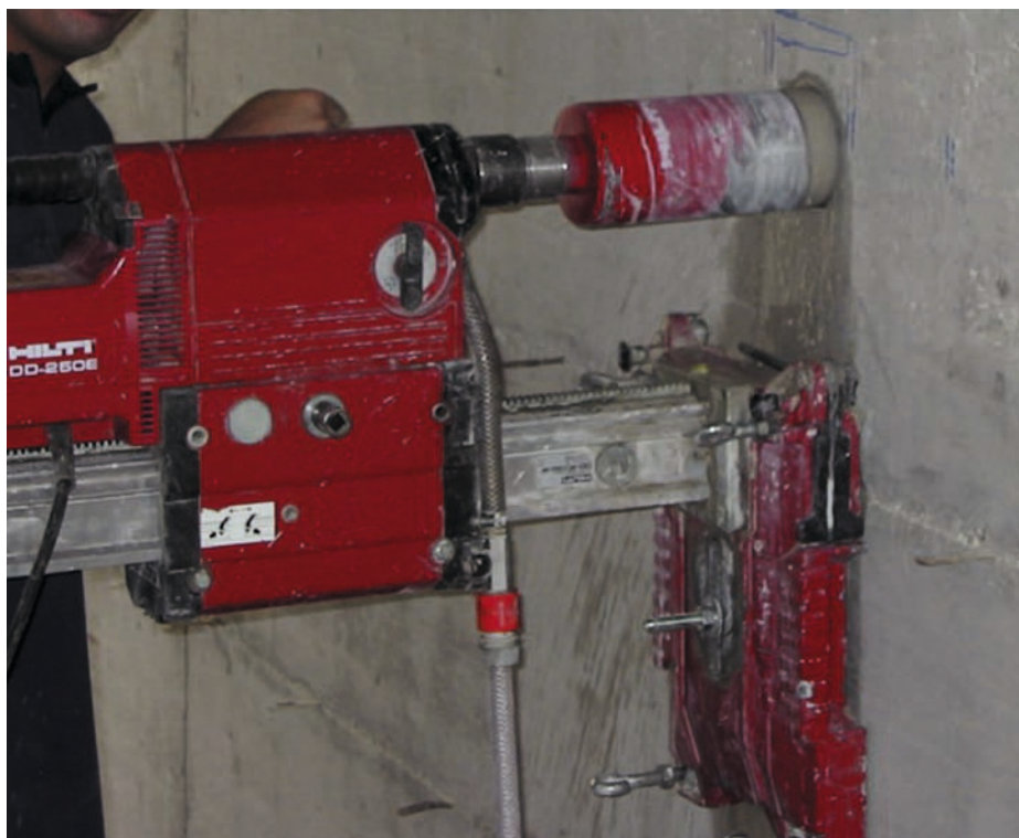
Prelievo di carote da un muro di contenimento
