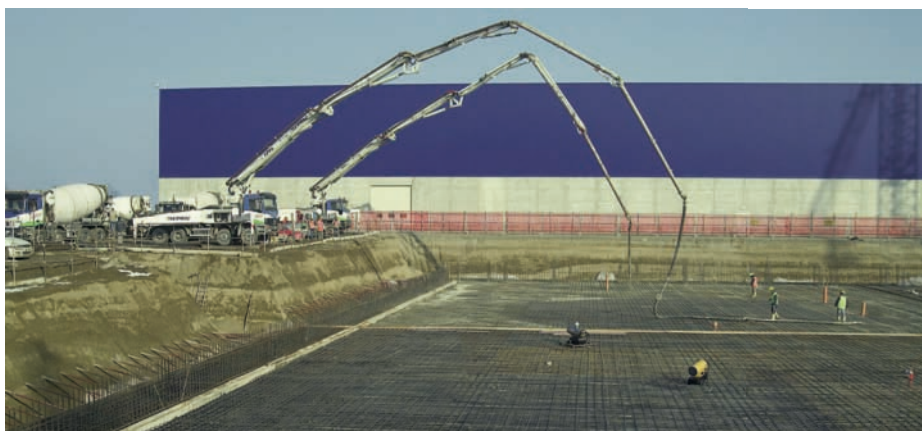
Platea di fondazione armata del silo meccanizzato - Ikea Deposito Centrale 2 - Piacenza getto di una platea di fondazione con calcestruzzo autocompattante fino a ridosso della maglia estradosale dell'armatura. La platea è stata completata e rifinita superficialmente con getto conclusivo in calcestruzzo superfluido.
