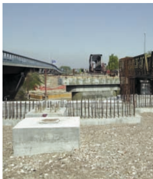
Ponte sul fiume Brenta. Quadruplicamento tratta funzionale Padova-Venezia Mestre
