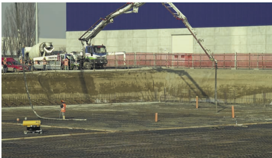
Getto pavimentazione - Ikea Deposito Centrale 2 - Piacenza
