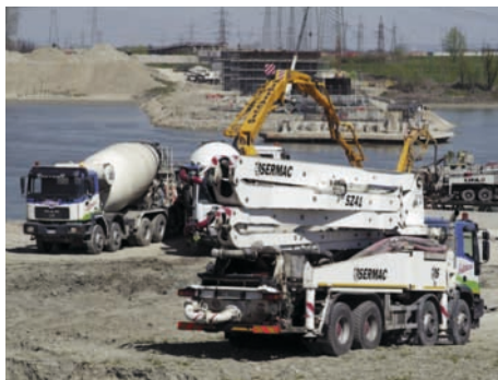
Getto in Alveo - Cantiere a Revere
