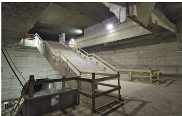
Realizzazione linea Metropolitana - Torino
