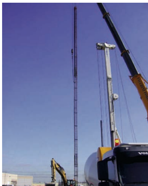
Affondamento della gabbia d'armatura dopo il getto di calcestruzzo per la realizzazione di un palo CFA.
