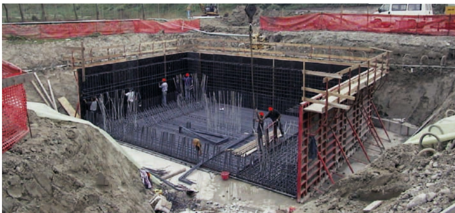
Preparazione del cassero e dell'armatura di un plinto di fondazione di una pila da ponte (volume complessivo di calcestruzzo 361.8 m 3 , spessore minimo de getto: 3 m) - per gentile concessione di Betonrossi S.p.A. - Piacenza.
