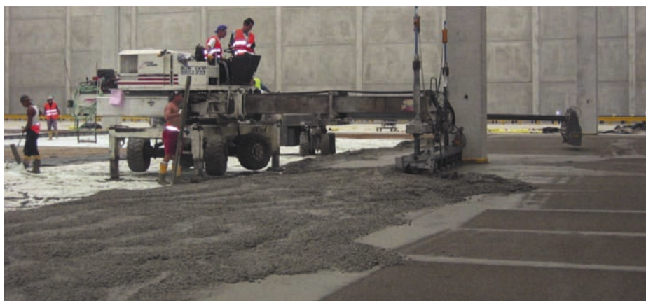
Ikea Cantiere Le Mose (PC)
