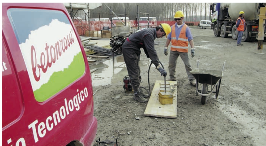
Confezionamento di provini in cantiere
