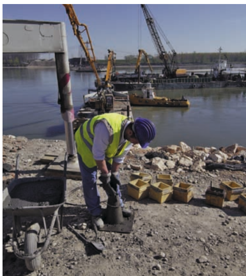
Prova di slump in cantiere a Revere
