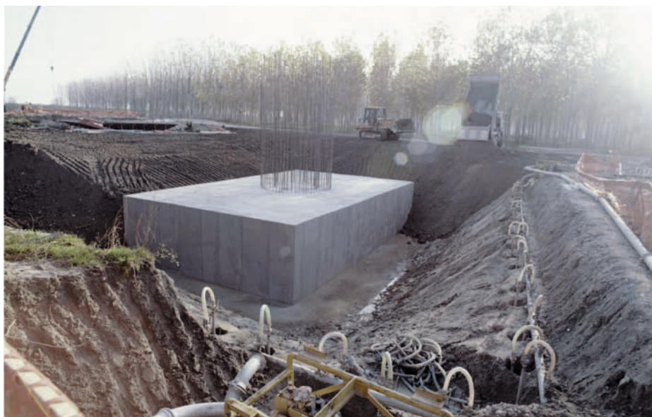
Plinto di Fondazione galena destra - Viadotto Po - Linea Ferroviaria TAV
