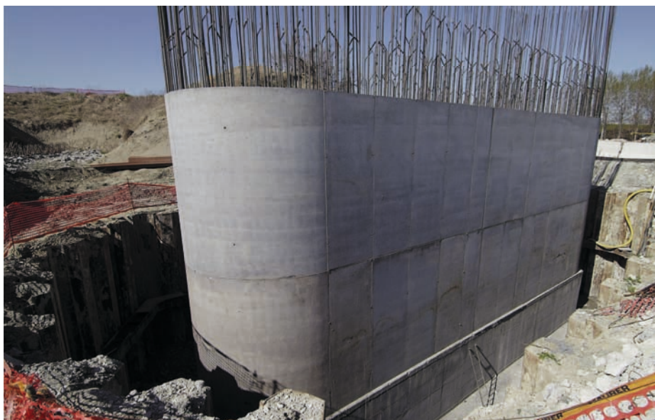
Pila lato Revere - Raddoppio Ferroviario - Direttrice Bologna-Brennero
