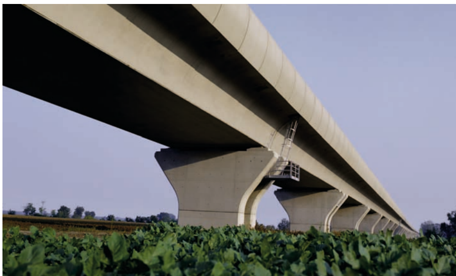
Linea Ferroviaria TAV - Viadotto Piacenza
